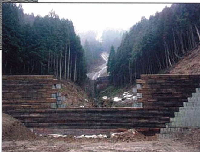
メッシュ型枠に間伐材張付け
