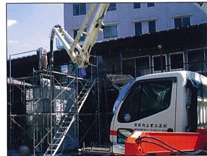
打設側圧試験
