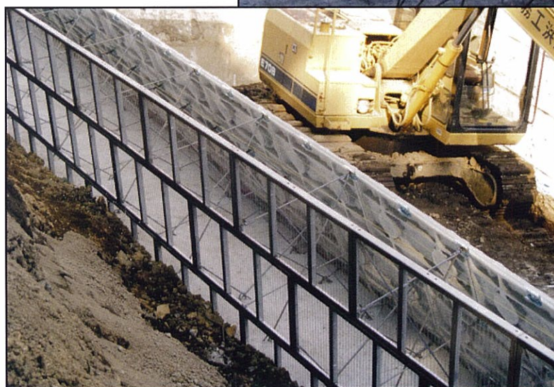
モタレ式擁壁等背面型枠使用例
