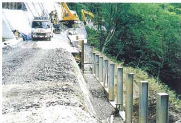
1.H鋼建込み・基礎コンクリート打設
