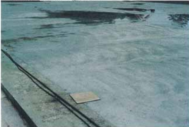
3.コンクリート打設(谷側)
