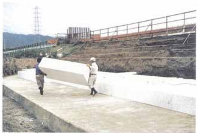
2.EPS設置作業状況
