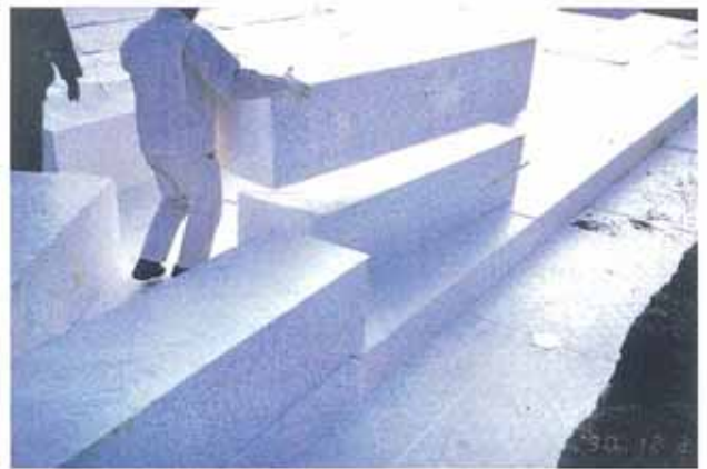
2.EPSカット品設置
