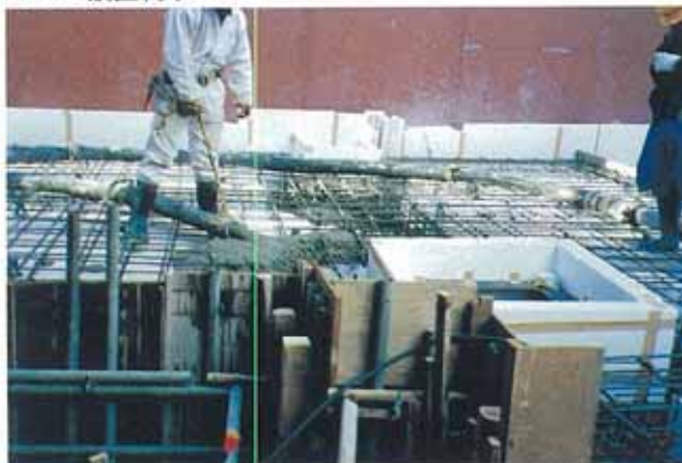
5. コンクリート打設
