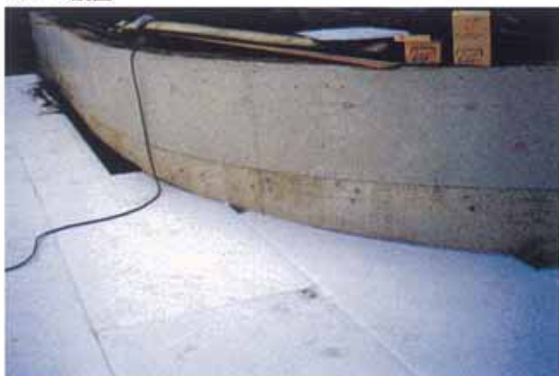
5.EPS曲線部カット状況
