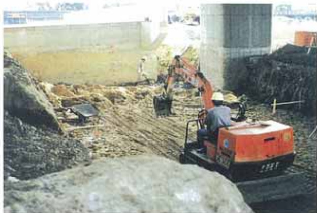
1.基盤掘削・地均し
