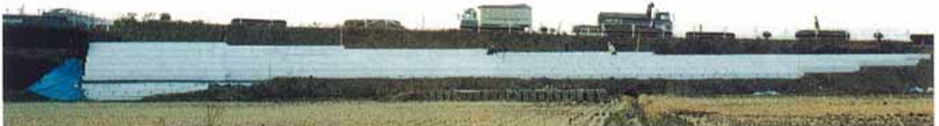
5. EPS設置終了・下り線(左側)
