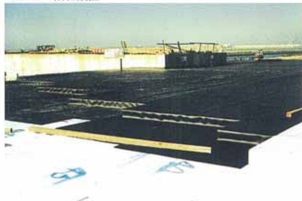
4. 遮水シート敷設
