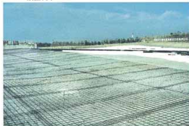
5.RC床版用メッシュ筋設置
