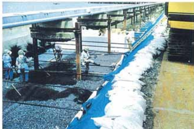
4.EPS設置とタイロッド塗装
