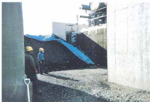
1. 下部碎石施工
