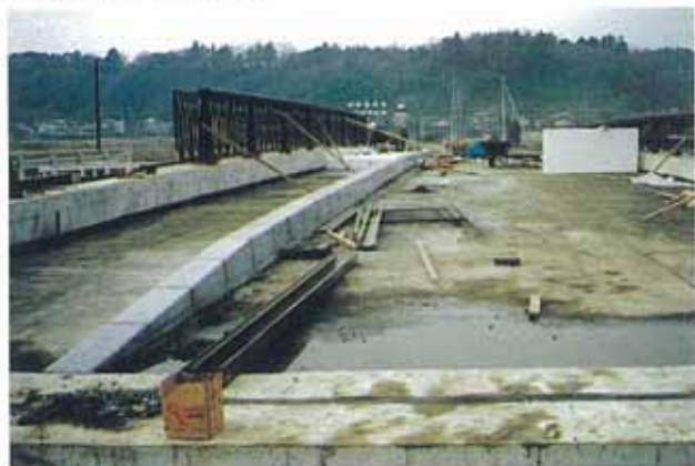
2.EPS設置前状況
