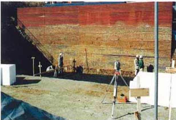
3. プレロード撤去・基盤整地
