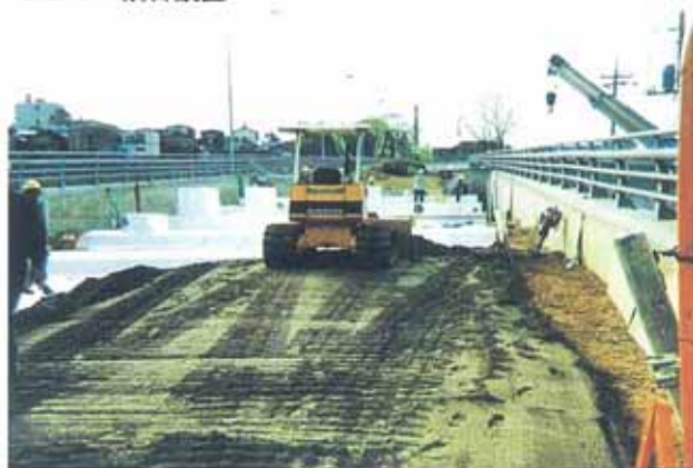
4. 路床・路盤施工
