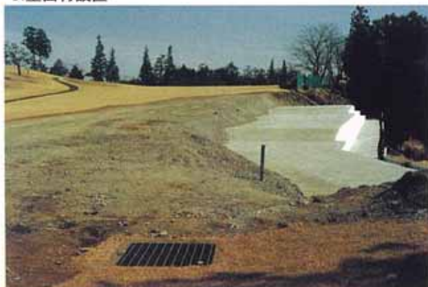
5. 最上部RC床版打設
