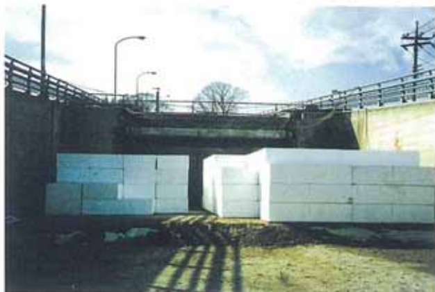
1. 基盤掘削・EPS搬入
