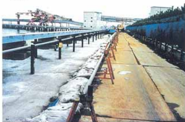
5.RC床版打設・埋戻し
