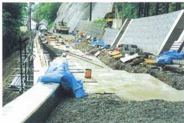
5.上部RC床版打設
