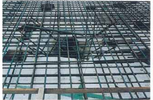
2.EPS設置部近景と配筋(谷側)
