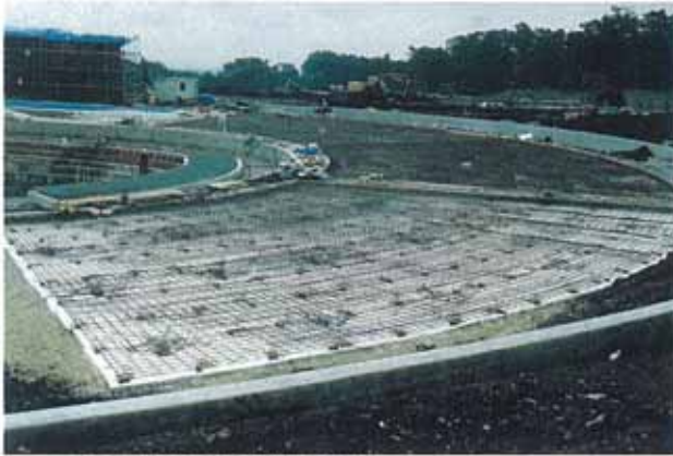
1.EPS設置部全景と配筋(谷側)
