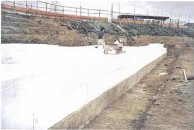
3.EPS二段目設置
