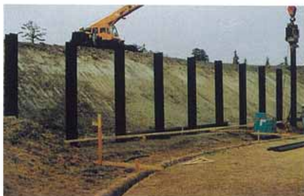
2. H鋼建込み
