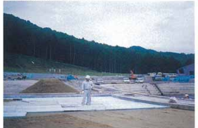
4.EPS設置(山側)
