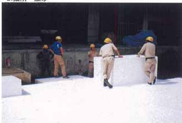
4.EPS設置(荷捌き部)
