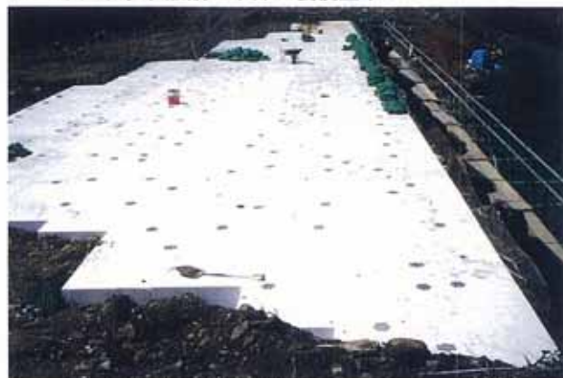
4.EPS設置及び土壌積上げ終了
