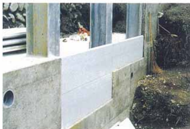
2.壁面材取付け
