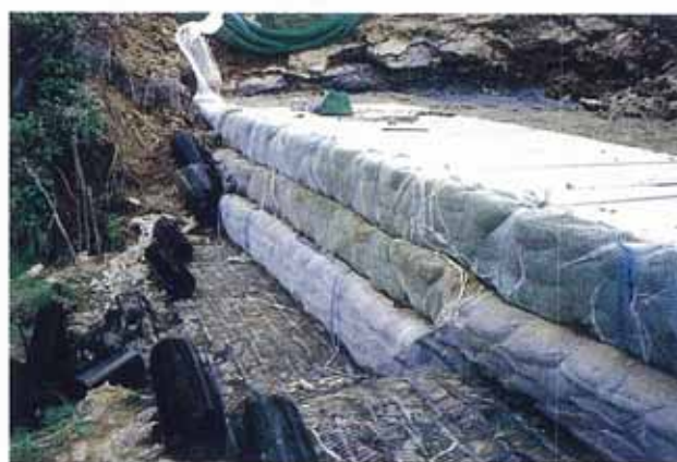
2.ジオグリッド敷設・下部土壌積上げ
