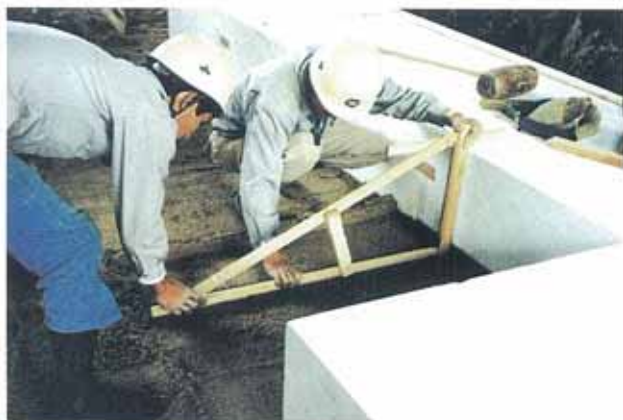
2.敷砂均し状況
