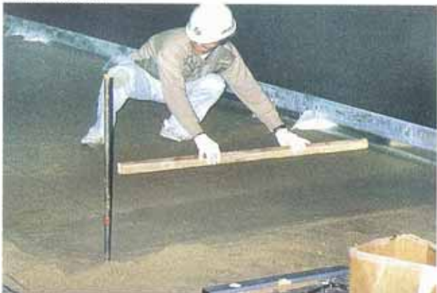
3.下部敷砂施工
