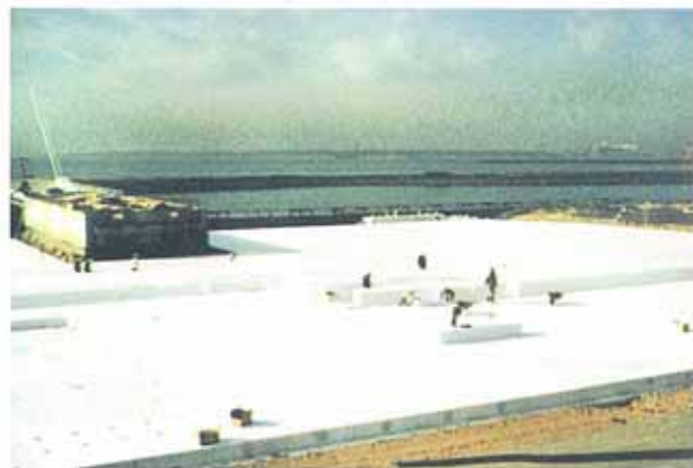
2.EPS二段目設置
