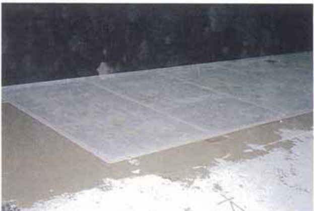
5.上部敷砂施工・木毛板設置
